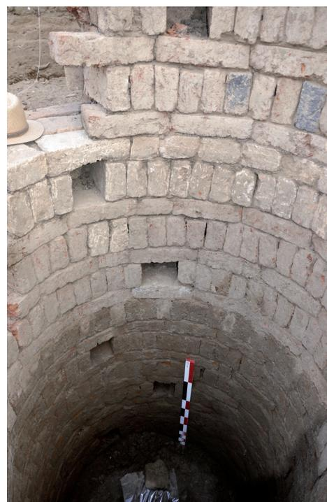
**Fig. 29.** Paroi occidentale du puits avec les trous de boulin. © CNRS-CFEETK/B. Durand.
